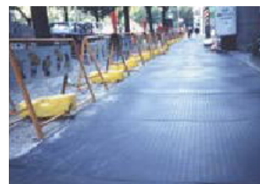
工事現場の歩行場所
