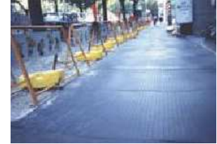
工事現場の歩行場所
