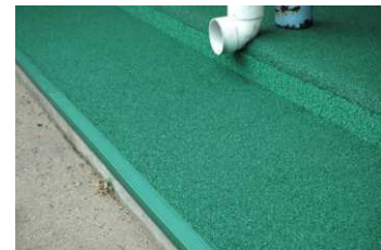
幼稚園のテラス改修工事 施工日:1日 カラー:DG4 厚み:20mm
